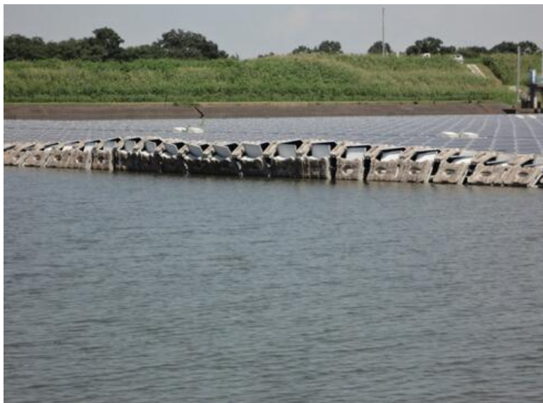
西侧两排电池板几乎全部翻倒
